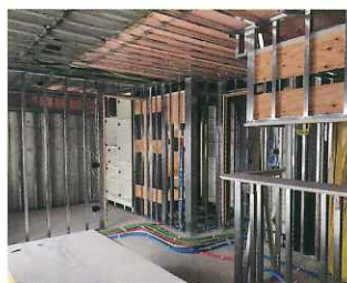
通電前の屋内作業に
